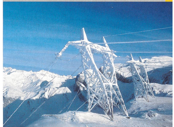
Schnee und Eis sind eine schwere Last für den Mast: In den letzten Jahren haben mehrtägige Kältewellen schon für grossflächige Stromunterbrüche in Europa gesorgt.
