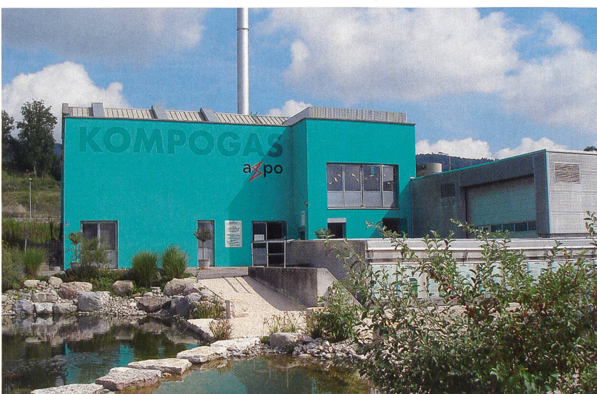
Bild 1 Kompogas-Anlage in Otelfingen.
