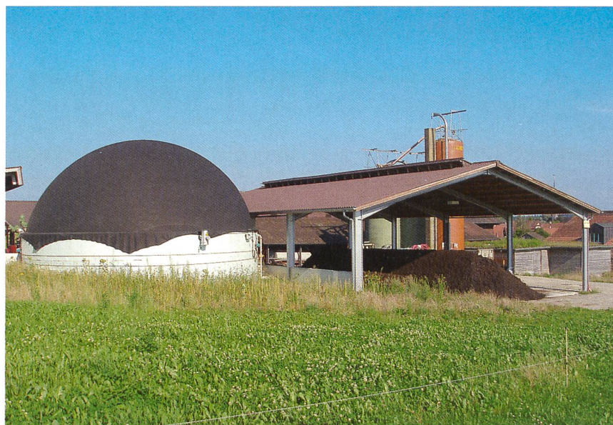
Bild 2 Landwirtschaftliche Biogasanlage mit Co-Vergärung und Nachkompostierung.
