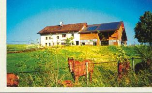
Auch Schweizer nutzen erneuerbare Energien: Bauernhof mit Solarenergie. Die thermische Anlage umfasst 12 m², die Fotovoltaikanlage 50 m² und die Holz-Biomasse verfeuert 16 m³ pro Jahr.
