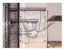
Patchkasten im Dirigon-System von Feller.
