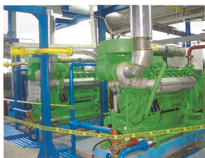
Das gesammelte Methan aus den Abwässern der Palmölproduktion dient der Stromproduktion.
