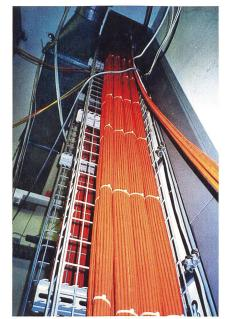
Bild 4 Worst Case für UTP: Parallele Führung der Kabel über lange Strecken macht das Alien NEXT praktisch unbeherrschbar.
