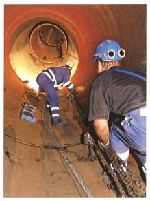
Figure 3 La réhabilitation consiste à chemiser l'intégralité du puits, c'est-à-dire à introduire des viroles à l'intérieur de puits existants sur plus de
