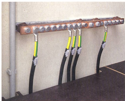
Eine saubere Erdung ist in der Trafostation wichtig.
