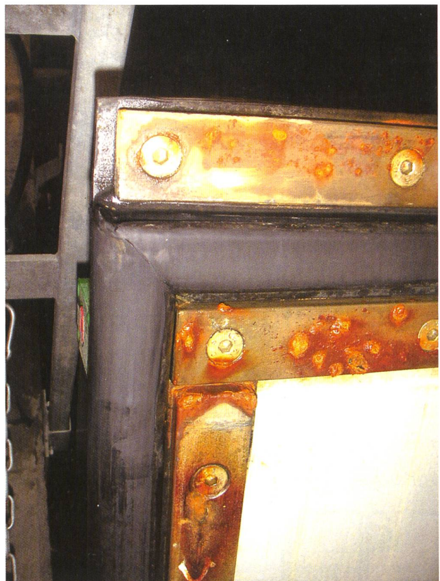
Bild 5 Korrosion an einem Segmentschütz mit starker Pustelbildung.
