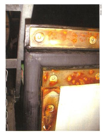
Bild 5 Korrosion an einem Segmentschütz mit starker Pustelbildung.
