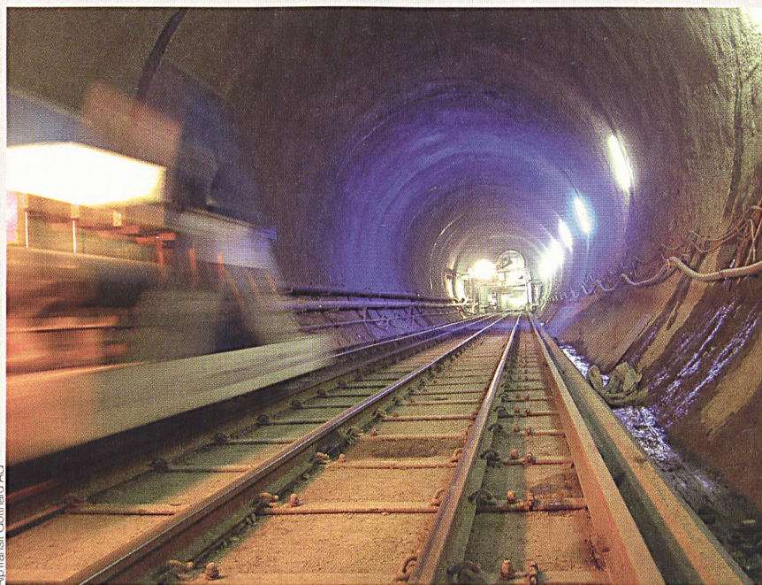
Das Konsortium kann für den Ausbau im Basistunnel bereits auf Erfahrungen zurückgreifen.
