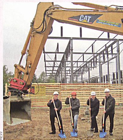
Der Spatenstich ist erfolgt, nun gehts zur Modernisierung.
