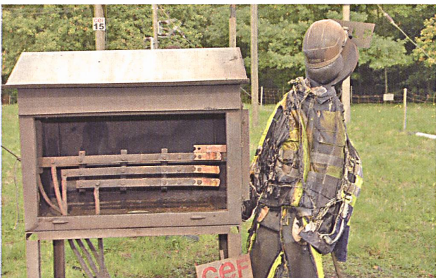
Richtige Arbeitskleidung: Verheerende Folgen nach einem Kurzschluss.
