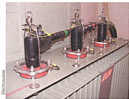
Figure 7 Circuit primaire du transformateur.
