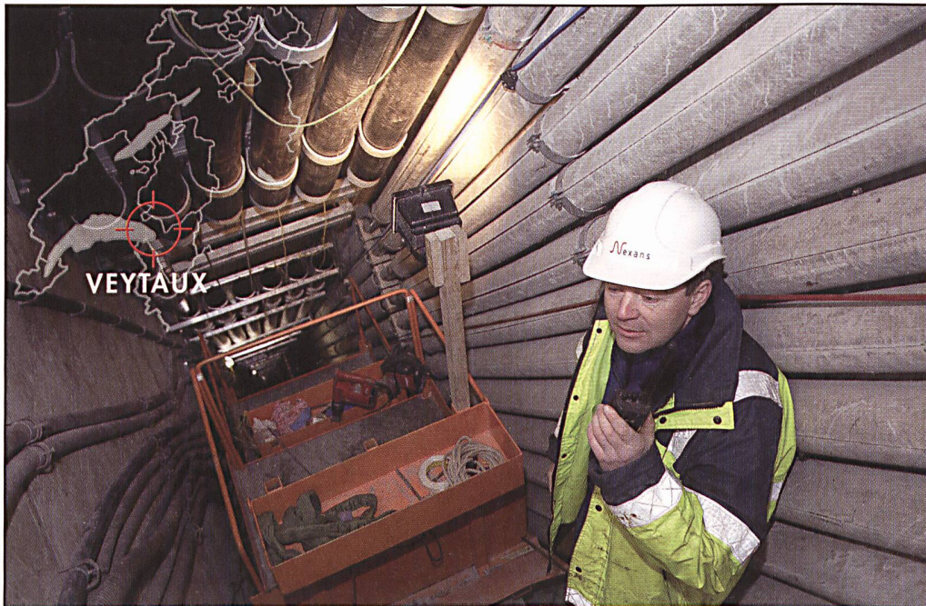
Projet: Renouvellement des 4 circuits de la centrale hydroélectrique de Veytaux. 11 km de câbles XAluVWT 1x300 mm 2 275 kV, avec accessoires haute tension et travaux de montage.
