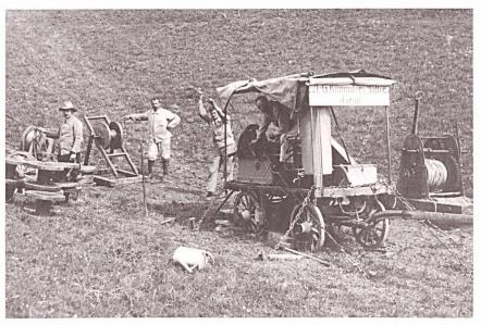
Bild 3 Pferdefuhrwerk mit Leitungsseil-Zugseinrichtung, deren Kraftquelle nicht identifizierbar ist. Genügte die Handwinde? Weder für den Leitungsseil-Einzug noch für den Mastaufzug finden sich Ausführungen zur Zugskraftquelle.
