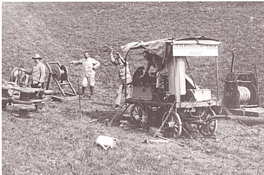
Bild 3 Pferdefuhrwerk mit Leitungsseil-Zugseinrichtung, deren Kraftquelle nicht identifizierbar ist. Genügte die Handwinde? Weder für den Leitungsseil-Einzug noch für den Mastaufzug finden sich Ausführungen zur Zugkraftquelle.
