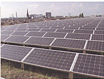
In Deutschland sind bereits rund 3 GW Fotovoltaikleistung installiert; die Schweiz liegt bei rund 30 MW. Im Bild: Fotovoltaikanlage mit 240 kWp auf dem Gründach der Messe Basel (2400 Siemens-SM-110-Panels, 7 Wechselrichter, Jahresertrag 220 000 kWh).
