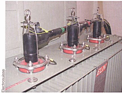
Bild 7 Primärseite des Transformators.
