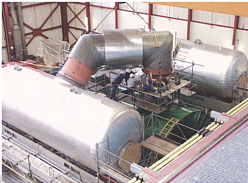
Zwei neue Wasserabscheider-Zwischenüberhitzer für Block 2 des KKB werden an die Turbinen angeschlossen.
