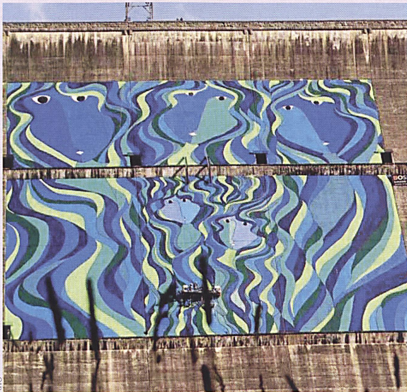
Staumauer wurde zur Künstlerleinwand.
