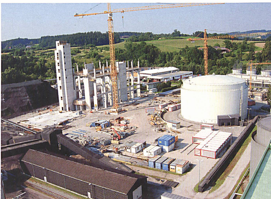
La centrale à cycle combiné (gaz et vapeur) en construction à Timelkam (Autriche).
