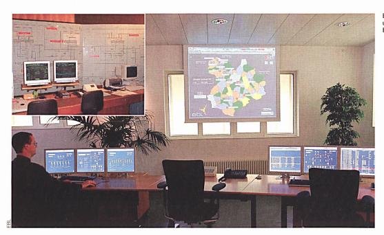
Bild 1 Blick in die alte und die neue Warte bei EBL.
