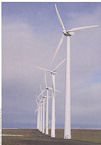
Condon Wind Farm in Condon, Oregon, USA: 43 Turbines des Typs Mitsubishi MWT600 liefern eine Leistung von 49,8 MW.
