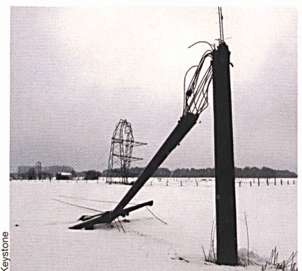
Figure 4 Des tours effondrées. Une tempête de neige accompagnée de vents violents ont récemment détruit des lignes électriques en Allemagne. Les normes de construction en vigueur n'excluent pas des ruines.
