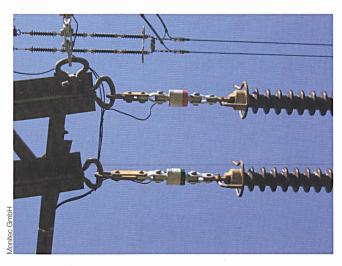
Bild 3 Die Kraftmesszellen werden zwischen den Isolatoren und den Abspannmasten eingebaut.
