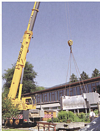
Installation des grössten Schweizer Pelletkessels.
