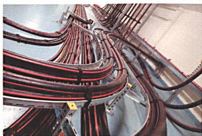
Aluminium/Aluminium-Mittelspannungskabel von Leoni Studer.
