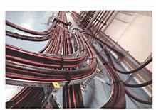
Aluminium/Aluminium-Mittelspannungskabel von Leoni Studer.
