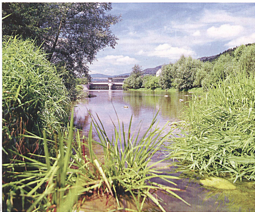
Prairie près de la centrale de Rapperswil-Auenstein: la taxe des eaux résiduelles est aussi importante pour le maintien de la diversité des espèces et l'existence des zones de promenade.
