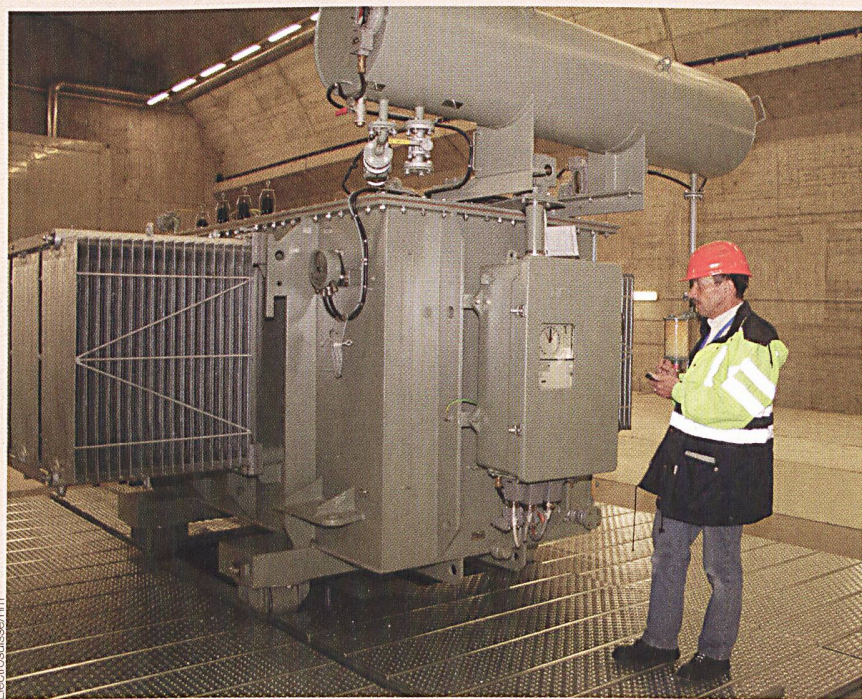
Kontrolle am Netzkupplungsstrafo der Netze von BKW FMB Energie AG und der Energiedienste Visp – westlich Raron AG (EVRW).
