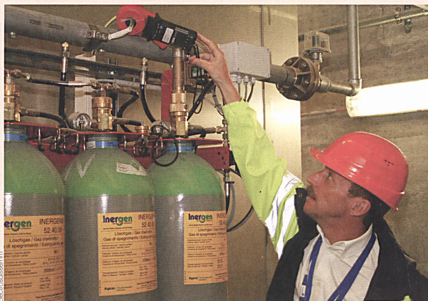
Erdschlaufenmessung an einer Löschanlage.
