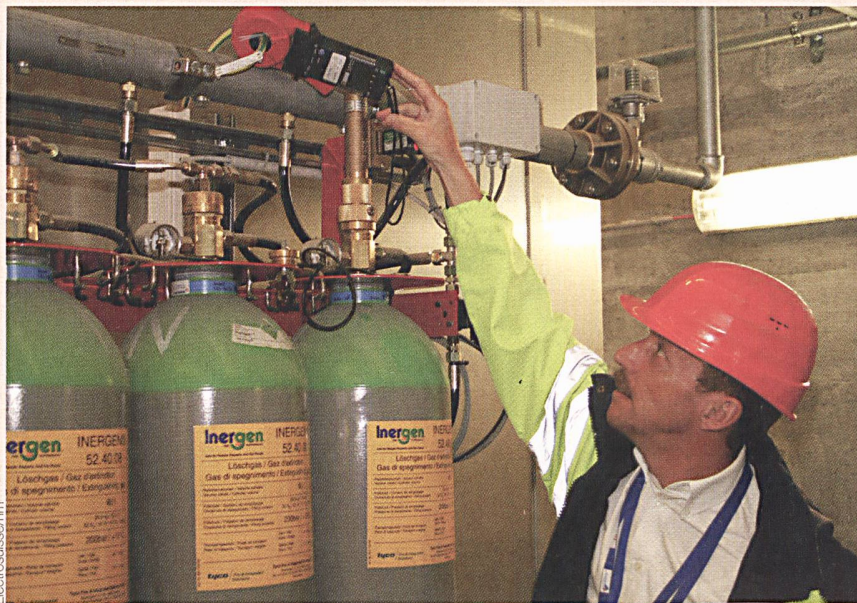
Erdschlaufenmessung an einer Löschanlage.
