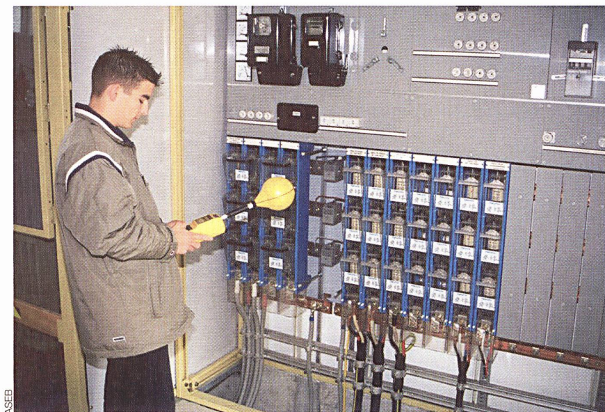
Bild 2 Magnetfeldmessung beim Elektroverteiler.
