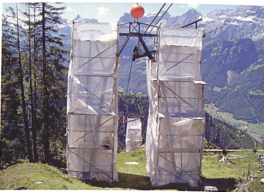
Bei der Erneuerung des Korrosionsschutzes war Vorsicht geboten.
