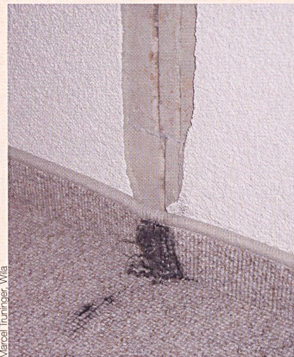
Ergebnis eines Blitzschlags durch eine Giebfassade, entstanden durch die Firstpfettenbefestigung mit einem Metallband auf der Betondecke; daher der Austritt des Blitzes über dem Boden.
