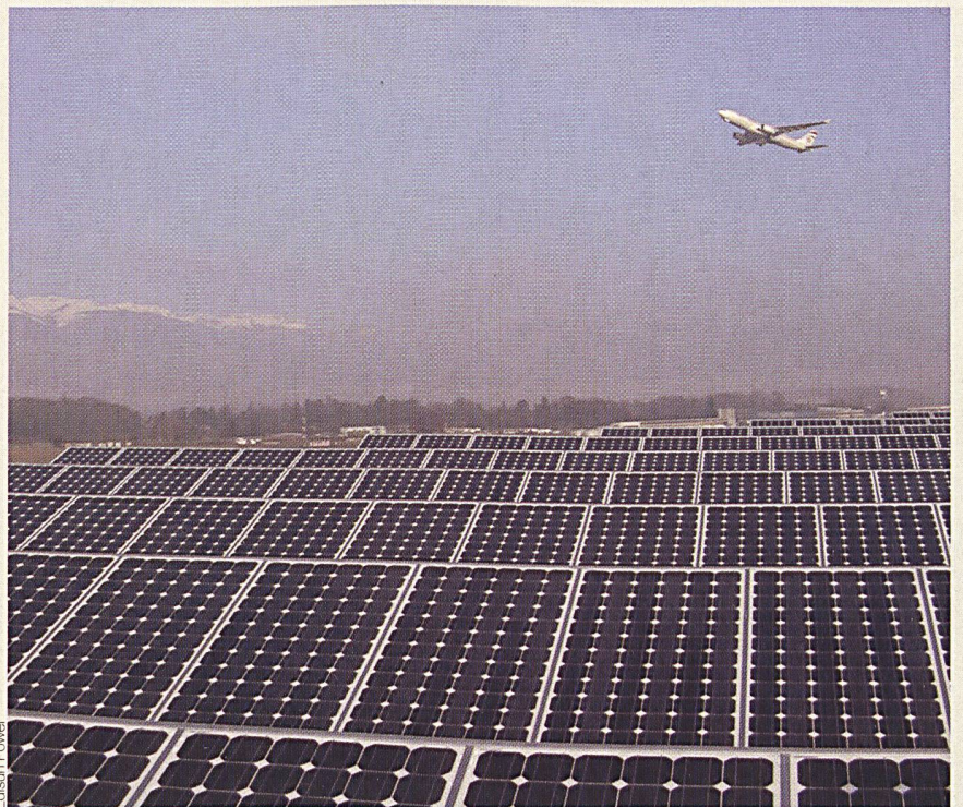
Edisun Power SA perce de nouveaux marchés.
