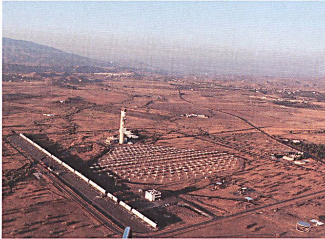
Plataforma Solar de Almeria: Die Strahlung wird ähnlich wie bei einem Brennglas in einen Brennpunkt (besser: Brennfleck) konzentriert, der sich auf der Spitze eines Turmes befindet (Foto: DLR).
