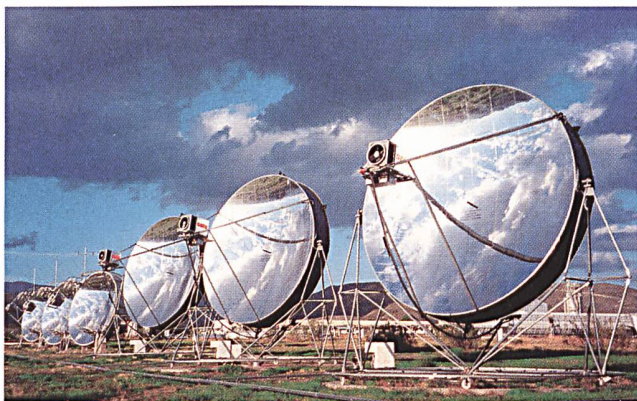
Dish/Stirling-Module können leicht zu einem Park bis zu einer Grösse von 5 bis 10 MW zusammengeschlossen werden (Foto: DLR).
