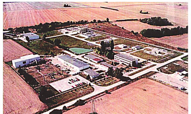
CO 2 SINK-Projekt: Bohrplatz Ketzin (Foto: VNG).
