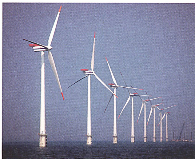
Der grösste Offshore-Windpark der Welt, Horns Rev (160 MW), liegt in der Nordsee, 14 bis 20 km vor der Küste Dänemarks.
