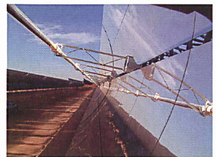
Solarthermisches Kraftwerk Andasol: hier werden Parabolspiegel installiert (Foto: Solar Millennium).
