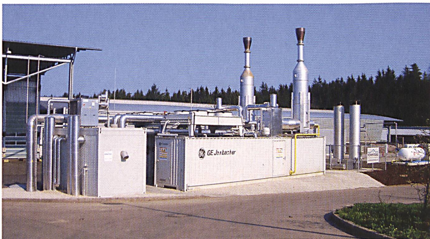
Blockheizkraftwerk mit zwei Gasmotoren/Generatoreinheiten.
