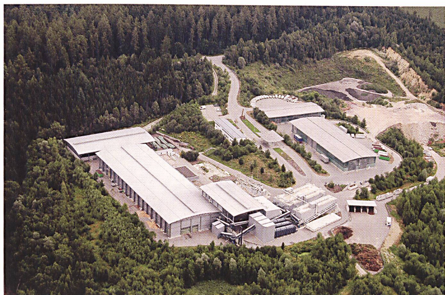
Entsorgungszentrum Passau mit Kompostierung und Biogasanlage (D).
