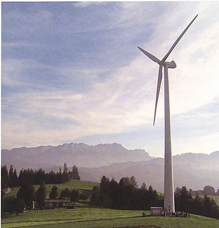
Die Windturbine oberhalb Entlebuch produziert Strom für rund 300 Haushalte (Foto: Suisse Eole).
