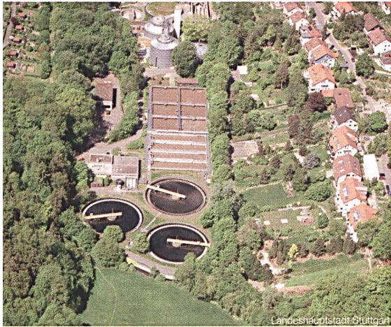
Im Klärwerk Stuttgart-Möhringen wird ab Sommer 2007 eine Hochtemperatur-Brennstoffzelle Nutzenergie aus Klärgas produzieren
