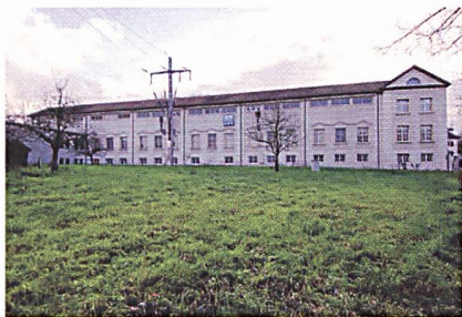
Das 80 Jahre alte AEW Unterwerk Wildegg wurde abgebrochen (Bild: aew).
