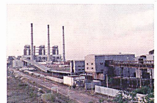
250-MW-Braunkohlekraftwerk in Neyveli (Tamil Nadu/Indien).
