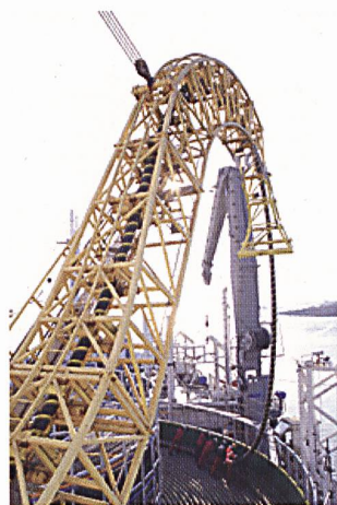
Unterseekabel wird verlegt (Bild ABB).
