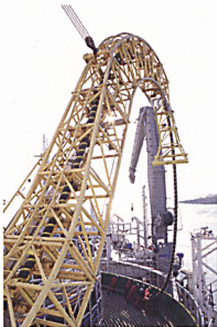
Unterseekabel wird verlegt (Bild ABB).
