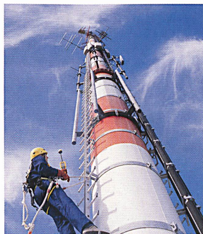
Feldstärkemessung mit dem Broadband-Field-Meter NBM-550 von Narda
