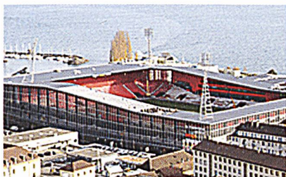
Les 750 m 2 de panneaux solaires fourniront l'équivalent de la consommation annuelle d'une vingtaine de ménages (photo: neuchâtel).
