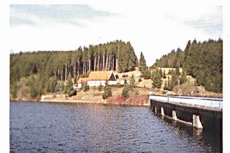
Talsperre in Königshütte (D).
