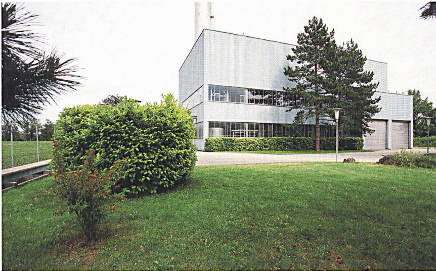
Centrale thermique actuelle de Cornaux.
