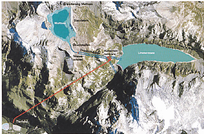
Übersicht über die Erweiterungsbauten beim Projekt Linthal 2015.
