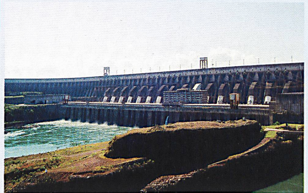
Bis zur Fertigstellung des Drei-Schluchten-Stausees in der Volksrepublik China im Jahr 2009 ist Itaipú (Bild) bezüglich der Leistung das grösste Wasserkraftwerk der Erde. Aufgrund der hohen Auslastung der Turbinen bleibt Itaipú hinsichtlich der Jahresenergieproduktion auch nach 2009 an erster Stelle.
