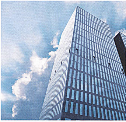
Die Arbeitsplätze in den 88 m und 72,5 m hohen Türmen des Sunrise Towers werden mit einer Komfortlüftung vor Überhitzung und Unterkühlung geschützt. Das gesamte Gebäude entspricht den Anforderungen von Minergie. (Bild: Archiv Oel)
