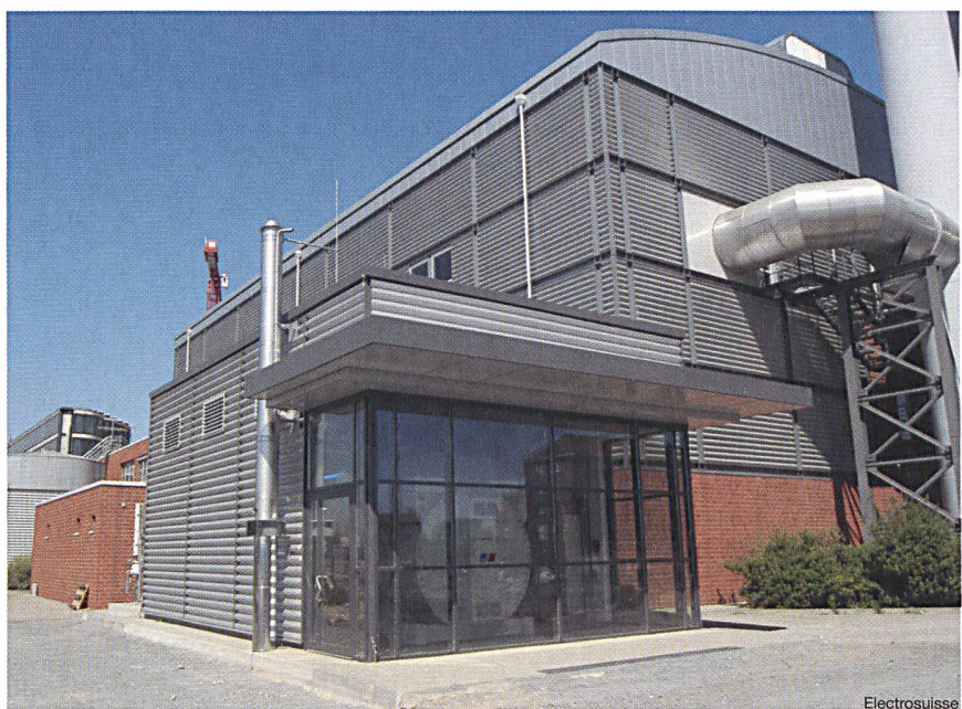
Bild 1 Brennstoffzellenanlage in der Hafencity in Hamburg (kleines Gebäude im Vordergrund)
