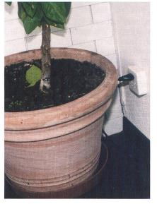
Bedingt durch die Steckdose des Typs 12 war es möglich, dass das Kind mit dem spannungsführenden Pol in Berührung kam. – Étant donné que la prise de courant était du type 12, l'enfant a pu entrer en contact avec le pôle sous tension.
