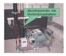
Beim Einschieben der Kabel in das Aluminiumrohr kontaktierte ein spannungsführender Draht des Steuerungskabels das Rohr und setzte es unter Spannung. – En introduisant les câbles dans le tube d'aluminium, un fil sous tension du câble de commande est entré en contact avec le tube et l'a mis sous tension.
