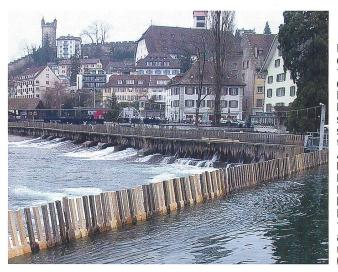
Luzern ersetzte um 1860 die Reuss-Schwelle des 16. Jahrhunderts, welche das Wasser zu den Mühlen leitete, durch ein Nadelwehr, Dieses stabilisiert den Wasserstand des Vierwaldstättersees und regelt den Abfluss der Reuss. Zur Regulierung werden die Nadeln noch heute von Hand herausgezogen bzw. hinuntergestossen. Einem Hochwasser wie 1999 kann die einzigartige Anlage jedoch nicht mehr standhalten (Bild: swissworld).
