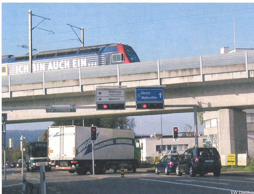
Bild 6 Die mit der SBB-Erde verbundene Lichtsignalanlage arbeitet seit 1997 störungsfrei
